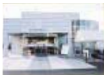
屋島支店 統合新築移転オープン
